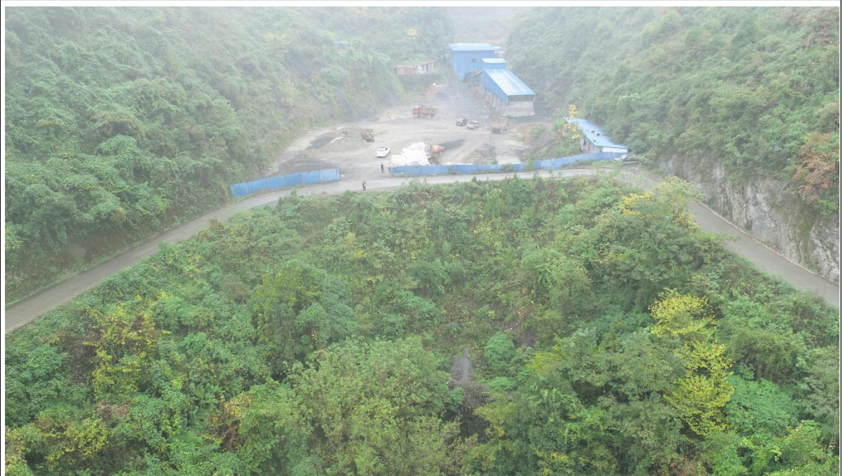
照片 4 弃渣场现状
